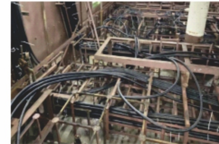
全船电缆换新 Replace all cables
